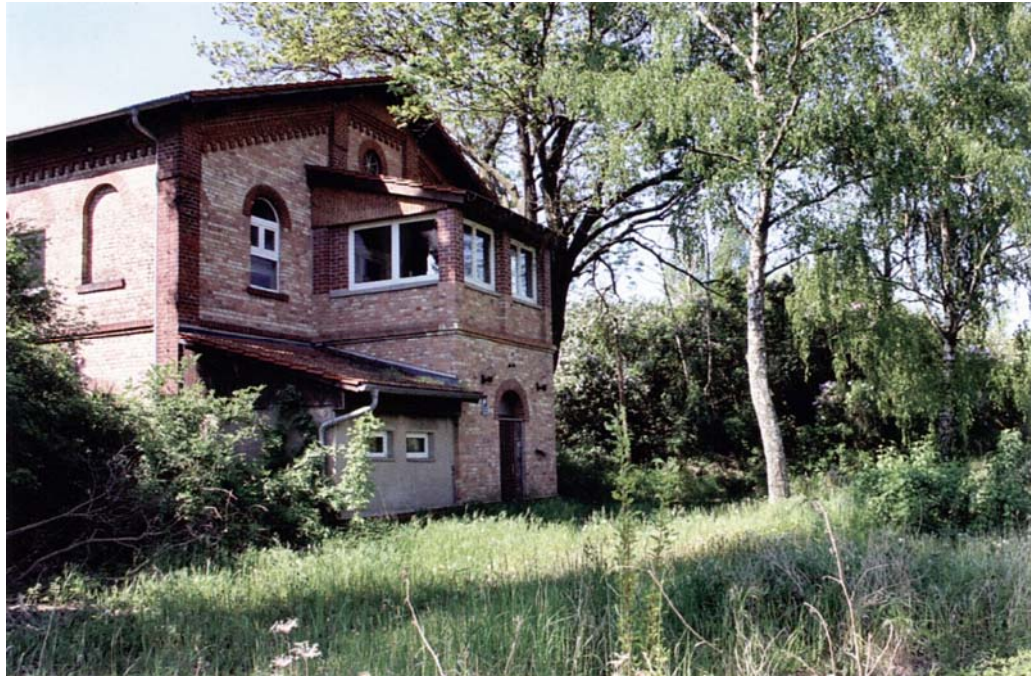
Abb. 239: Ehemaliges Betriebsgebäude und stark zugewachsene Abteufhalde des Schachtes Oberröblingen (2008)
