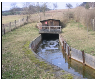
Bild 8: Mundloch des Schlüsselstollens
