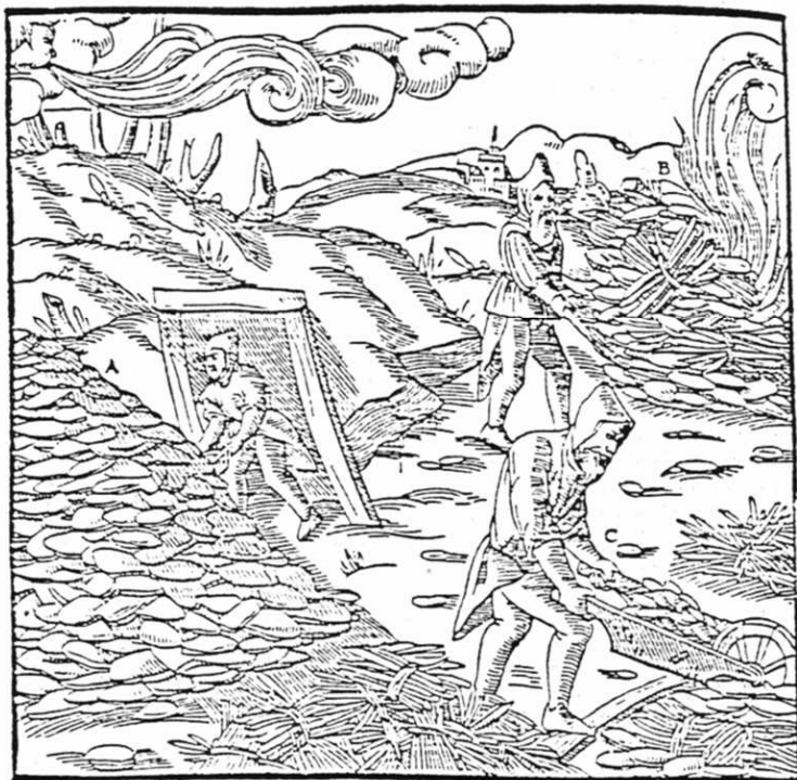
Der Erzhaufen A. Der entzündete Erzhaufen B. Ein Arbeiter, der Schiefer auf das Strauchwerk schafft C.
