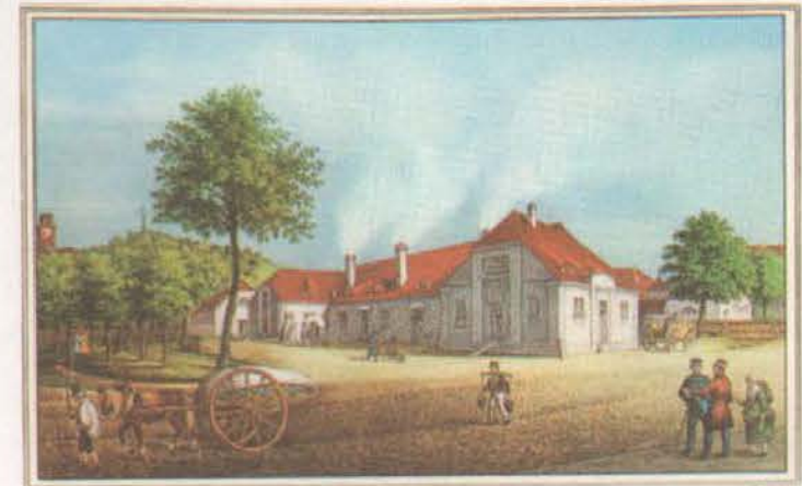
Der Kupferhammer in Rothenburg nach Giebelhausen 1836.
