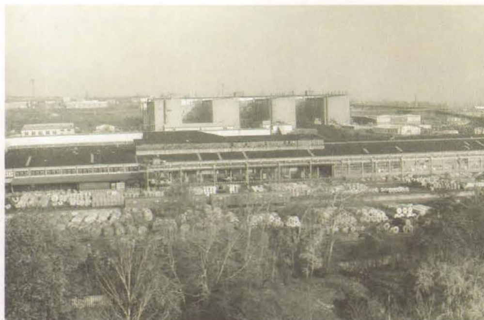
Blick auf die Zieherei und Lackdrahtfabrik von der „Wesselburg“ aus.
