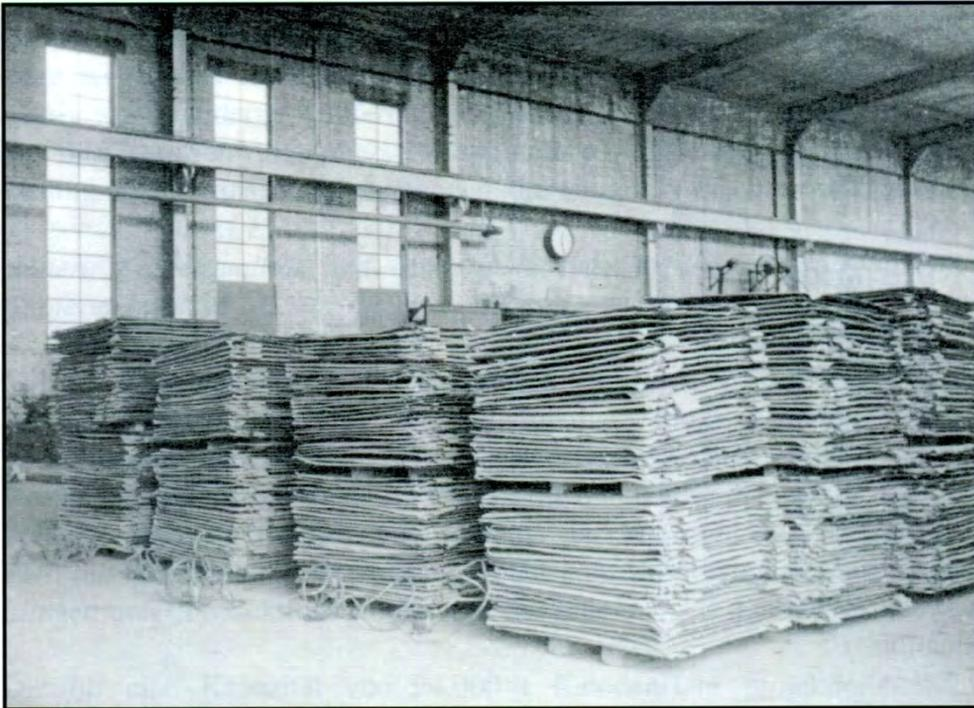
**Abbildung 45:** Kupferkatoden in der Lagerhalle
