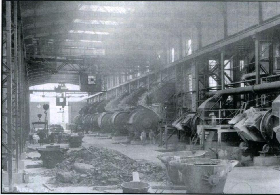
**Abbildung 38:** Halle der Bessemerie mit 7 Konvertoren
