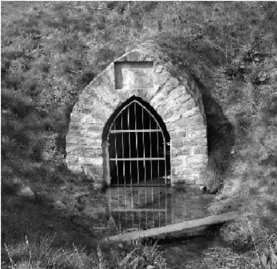
Abb.8 : Mundloch des Jacob-Adolph-Stollens
