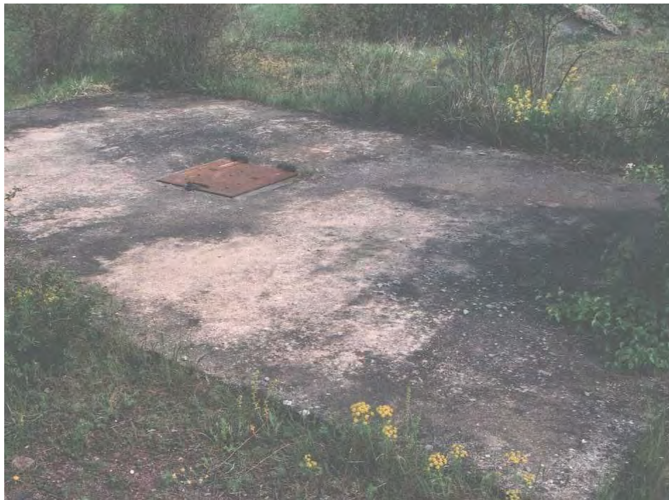
Abb. 6a: Schacht Wettin, Schachtdeckel 2006
