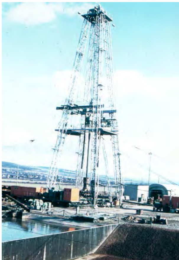
Abb. 19: Der Teufturm für den Bohrschacht Brücken 1
