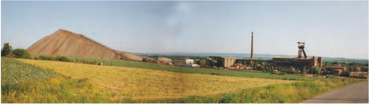
Abb. 12: Gesamtansicht der Schachtanlage B.-Koenen 1 von N um 1992
