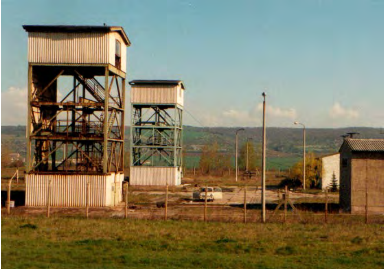
Abb. 23 Die Bohrschächte Brücken nach der Verfüllung (um 1994)
