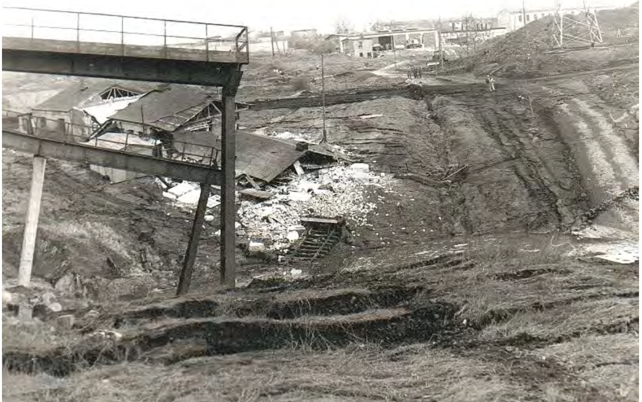
Abb. 24: Details zu den Schäden im Bereich Karl-Liebknecht-Hütte 1976
