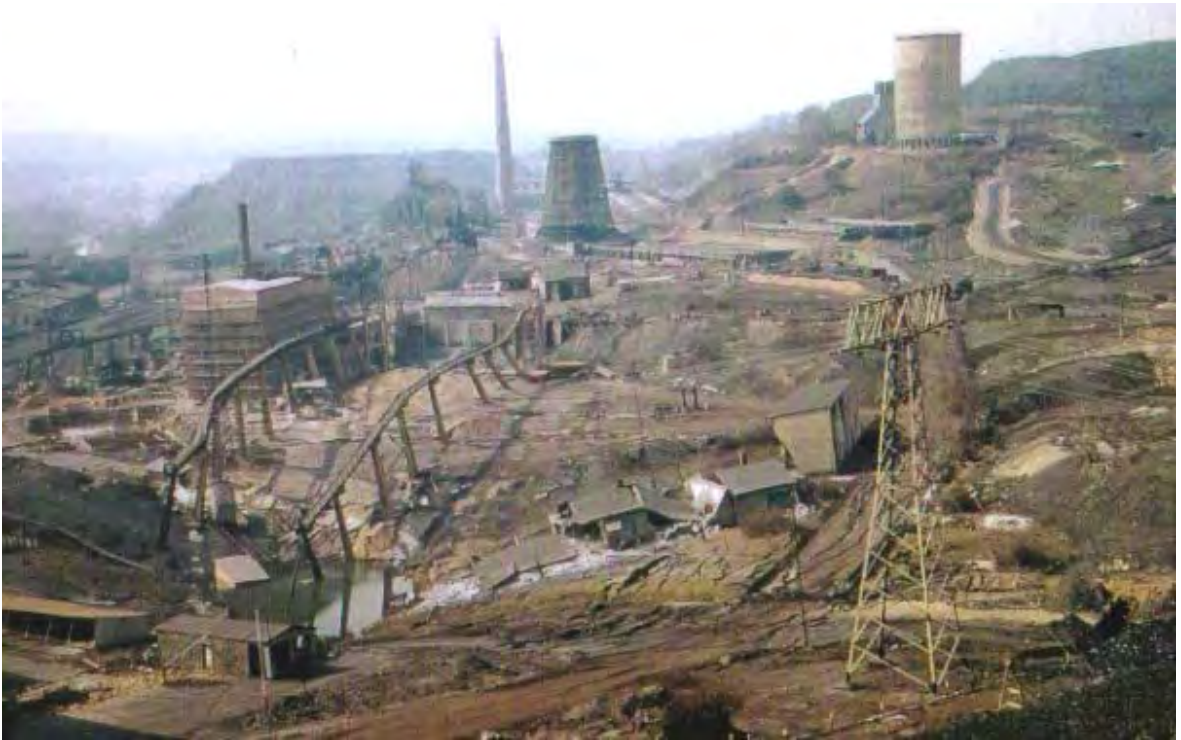
Abb. 23: Senkungszentrum beim Schadensfall K.-Liebknecht-Hütte 1976 (Blick v. Osten)
