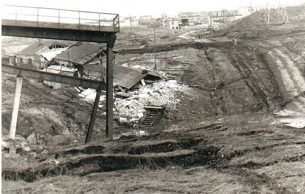
Abb. 17: Detail zu den Schäden im Bereich der K.-Liebknecht-Hütte (Kranbahn) 1976
