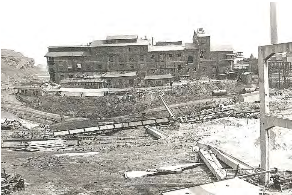
Abb. 18: Detail zu den Schäden im Bereich der K.-Liebknecht-Hütte (Vanadinanlage) 1976
