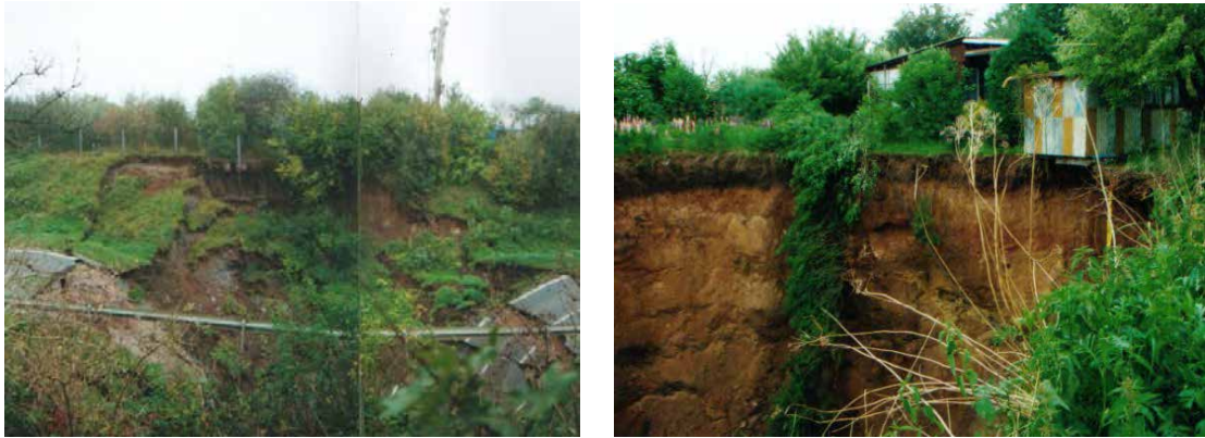
Abb. 27a und 27 b: Schäden an der B 180 bei Eisleben (ca. 2000)
