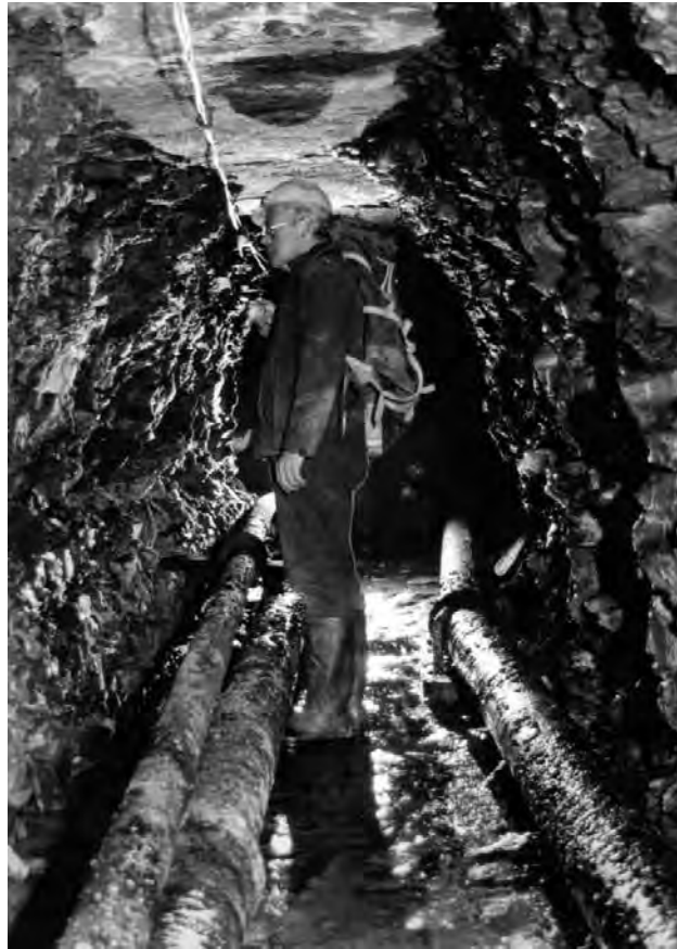
Abb. 16e: Rohrleitungen vom Froschmühlensollen zur Pumpstation W-Schacht
