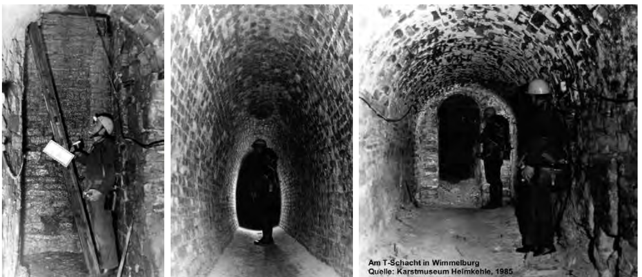
Abb. 16a-c: Fahrtentrum des T-Schachtes und Strecken am T-Schacht
