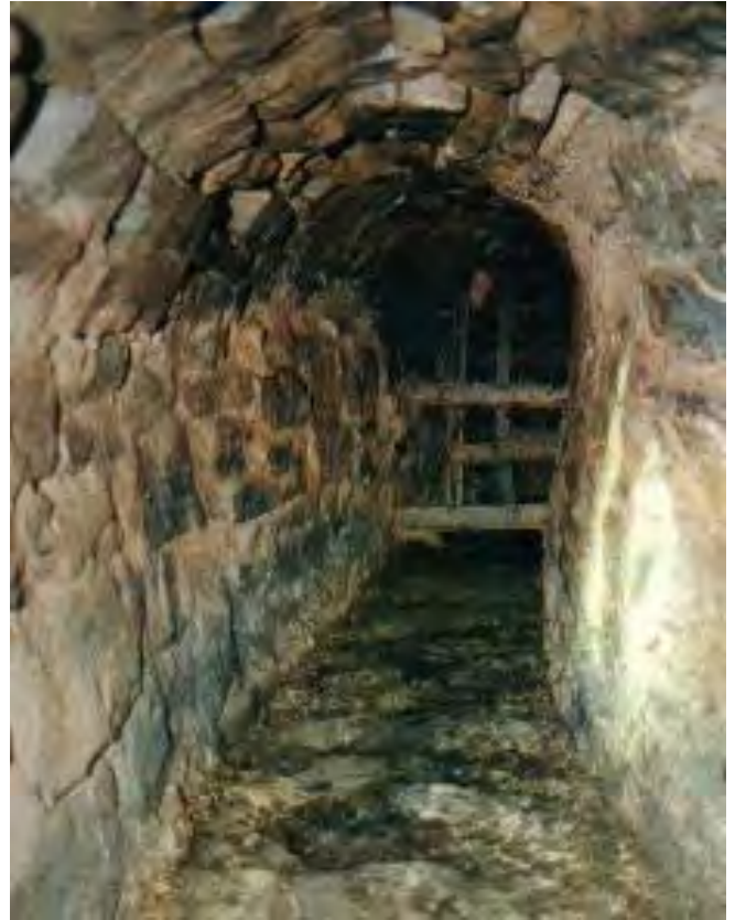
9a: Blick in den Gonnaer Stollen
