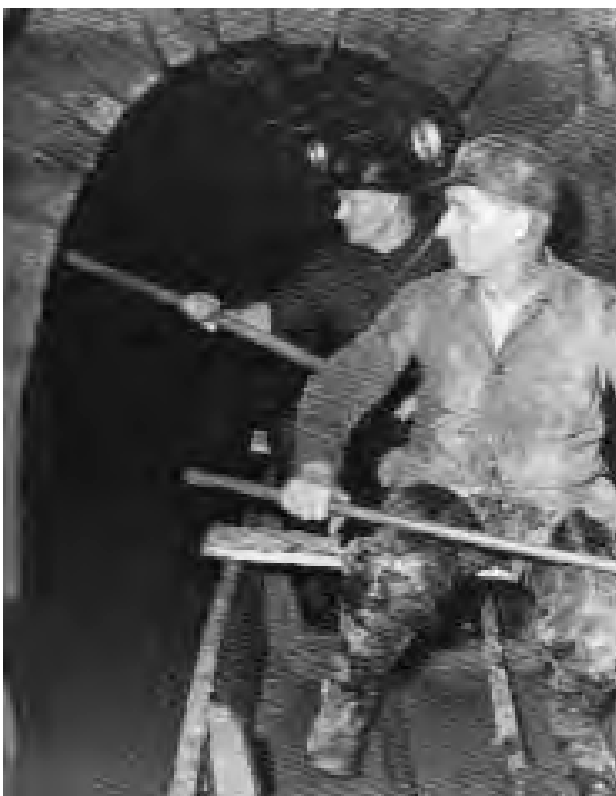
Abb. 14 a: Befahrung des Schlüsselstollens per Kahn
