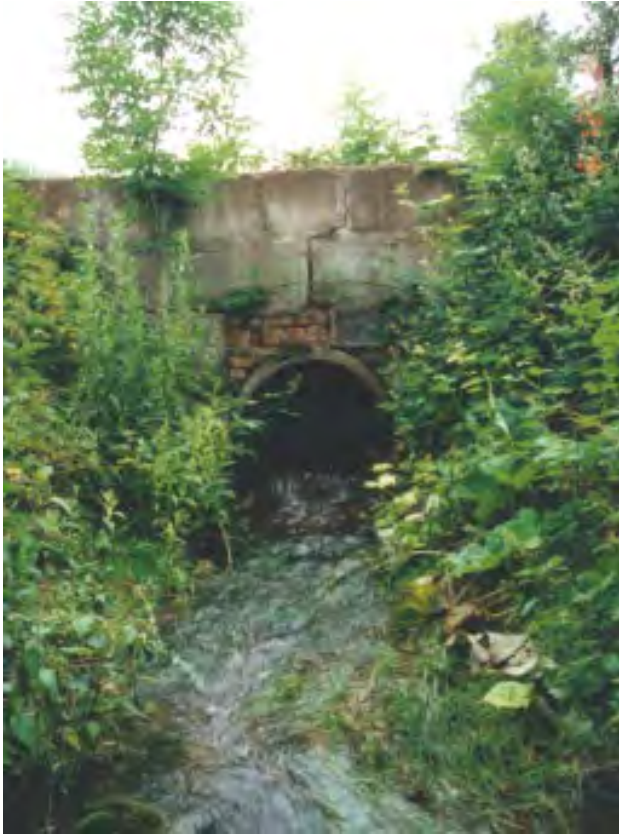
Abb. 9: Das 1983 neu angelegte Mundloch des Gonnaer StollensAbb.
