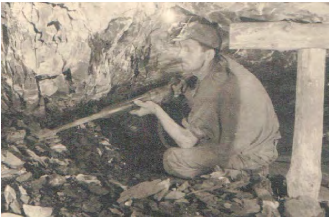
Abb. 16: Häuer mit Presslufthammer vor Streb
