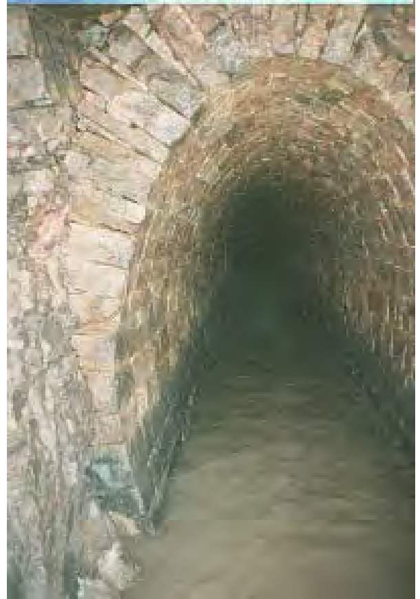
Abb. 15a: Blick in ein in Mauerung gesetztes Teilstück des Seegen-Gottes-Stollns
