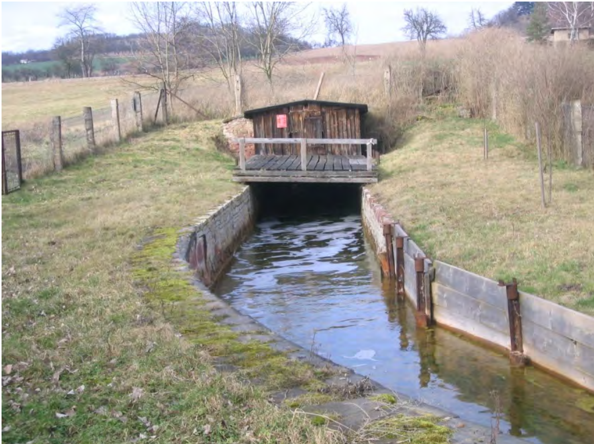
Abb. 14: Mundloch des Schlüsselstollens bei Friedeburg
