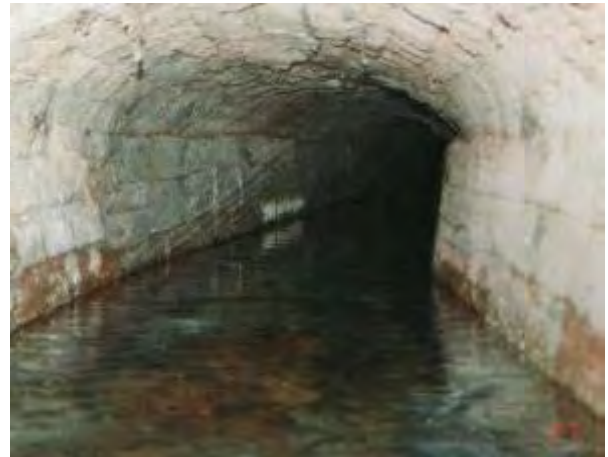
Abb. 11 a: Blick in den Froschmühlen-Stollen
