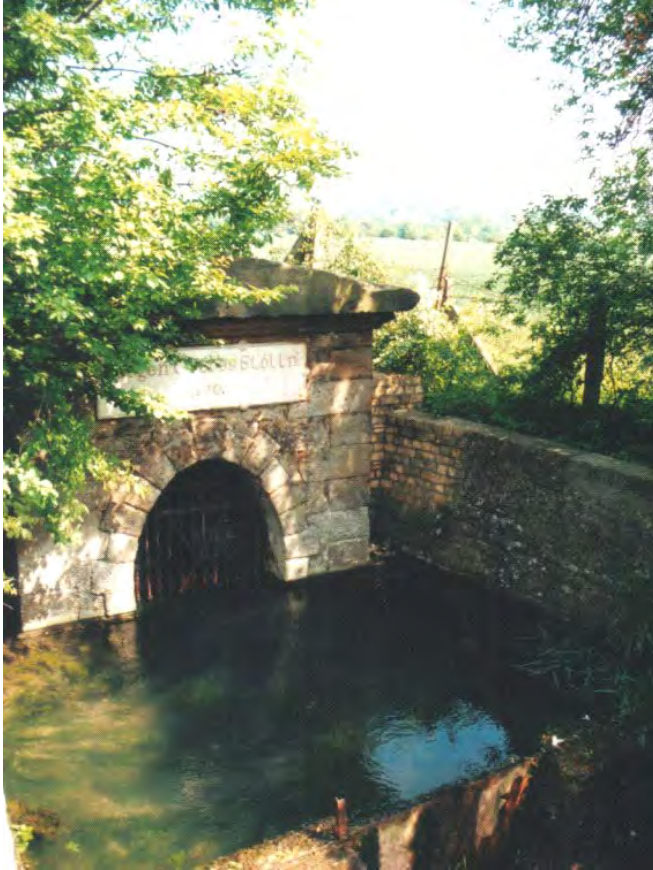
Abb. 15: Mundloch des Seegen-Gottes-Stollns bei Sangerhausen
