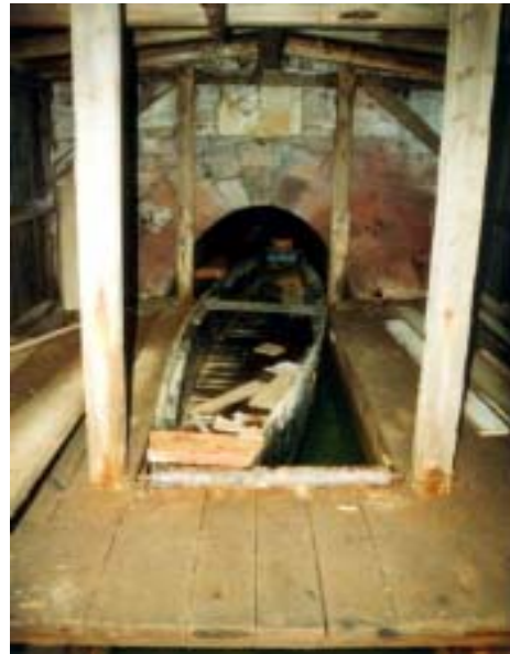
Abb. 18: Kahn am Mundloch des Schlüsselstollens
