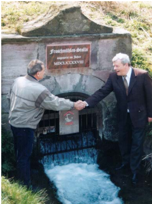
Abb.7: Mundloch des Froschmühlenstollens
