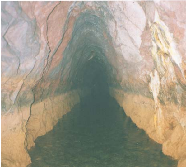
Abb. 14: Schlüsselstollen ohne Ausbau
