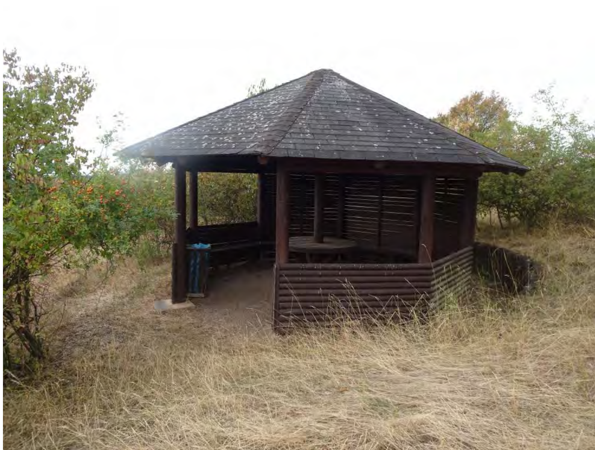
Wetterschutzhütte (Foto P. Sauerzapfe)
