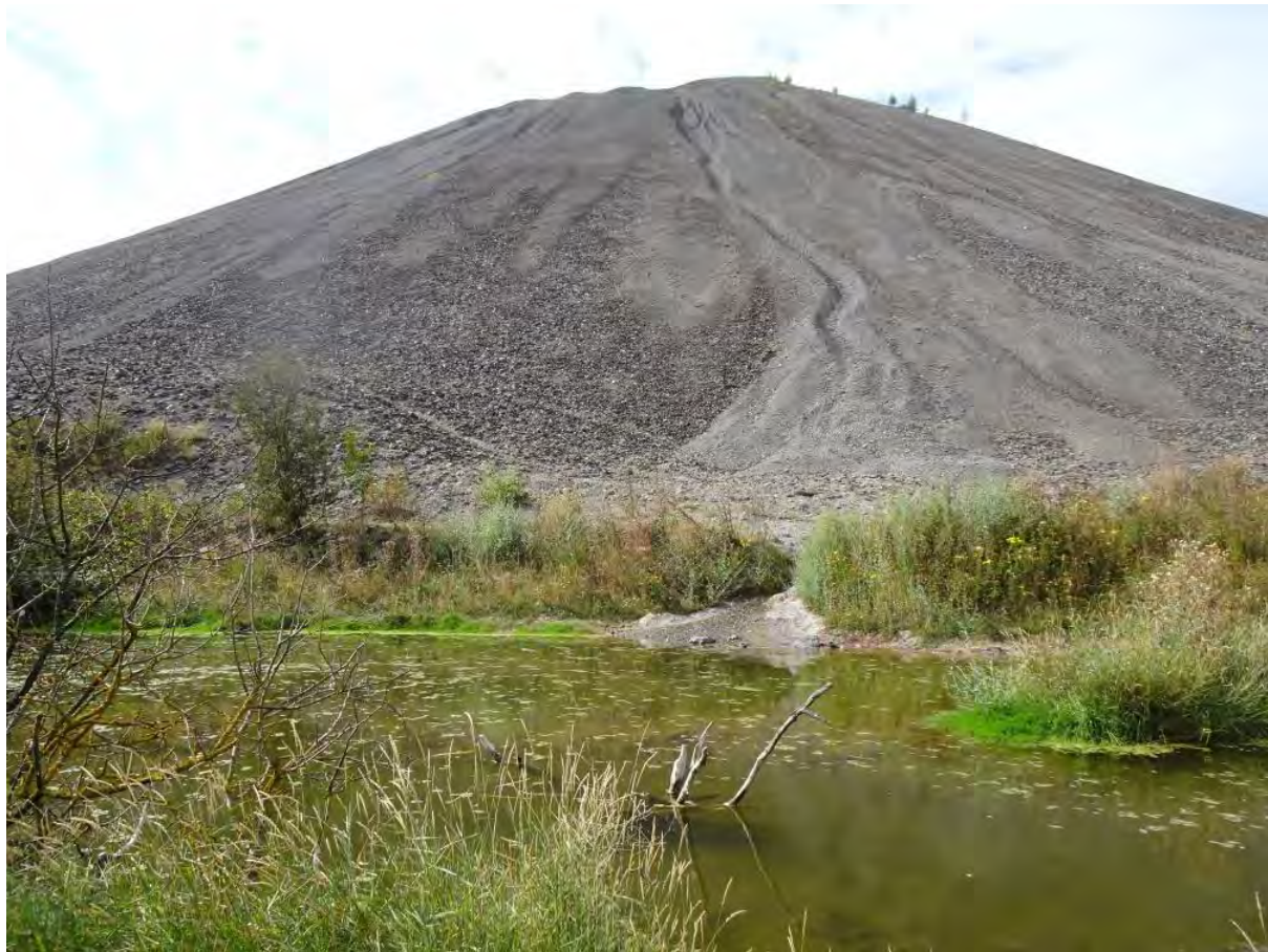
Sickerwasseraustritt (Foto P. Sauerzapfe)
