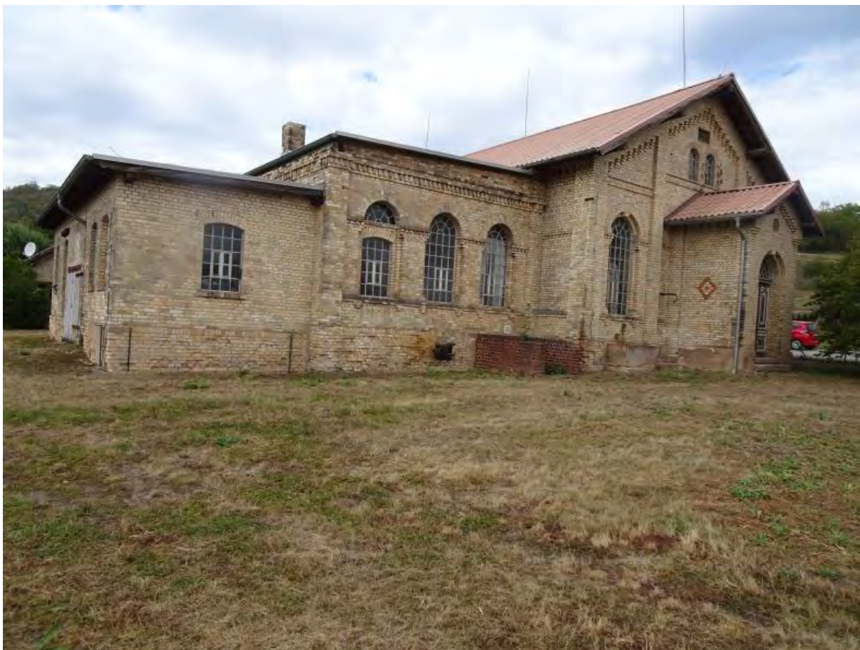
Wasserwerk (Foto P. Sauerzapfe)
