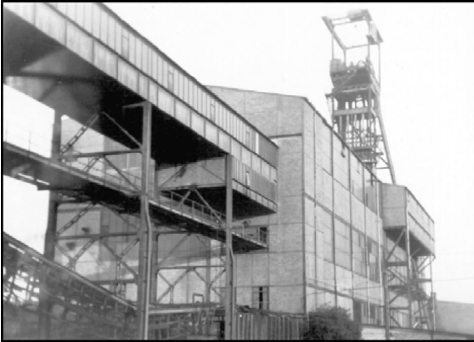
Abbildung 119: Treibehaus, Bandbrücke zum Erzverladebunker und Beladestation Höhenförderer (Bernard-Koenen-Schacht)
