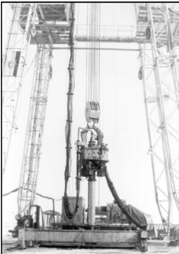
Abbildung 42: Schachtbohrgerät (Kraftspülkopf, Bohrstrang, Bohrkleinaustrag) Schachtbau Nordhausen
