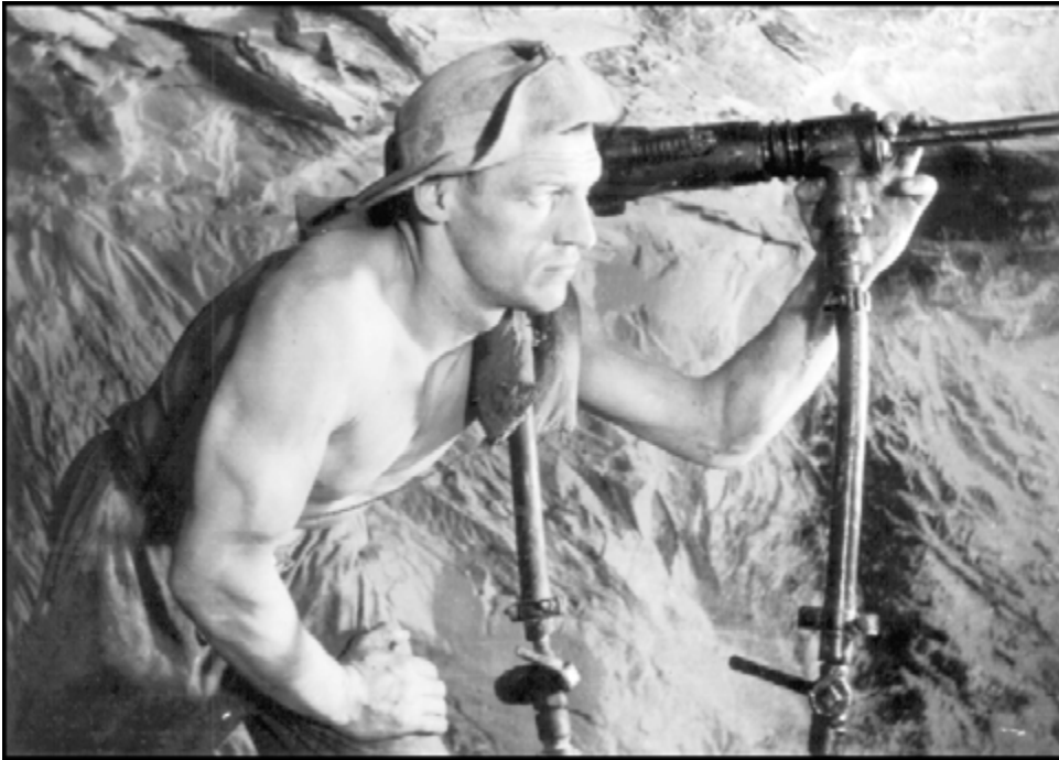
Abbildung 53: Schießhauer im Ortsbetrieb bei der Bohrarbeit (Vitzthum-Schacht, September 1949)
