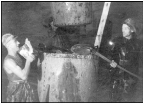
Abbildung 27: Ladearbeit auf der Schachtschleife (Sangerhäuser Schacht, 10. September 1949)
