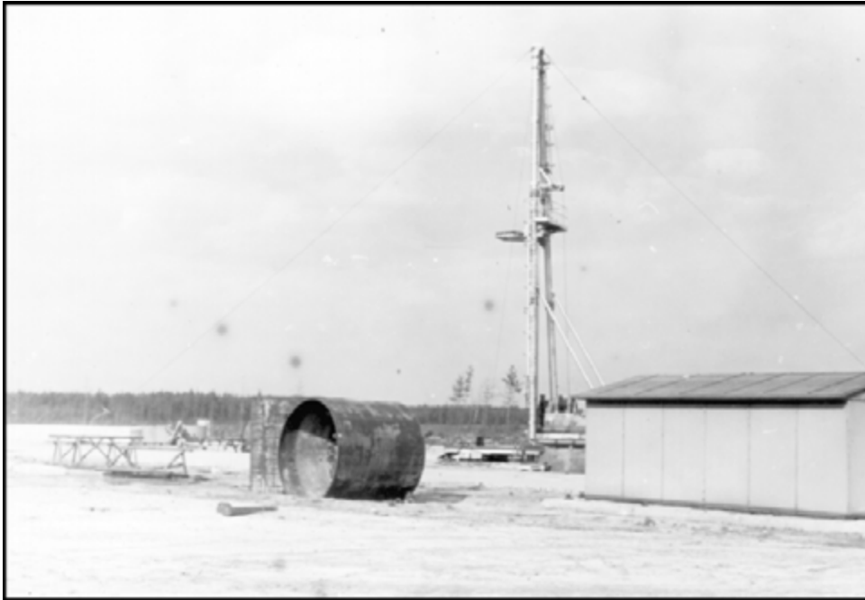
Abbildung 47: Baustelleneinrichtung, Schachterkundungsbohrung (Kupfererzschachtanlage Spremberg)
