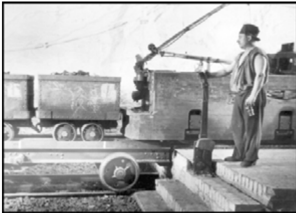
Abbildung 21: Abziehen Lastzug vom Unterwagen in Übergabe 9. Sohle (Vitzthum-Schacht)
