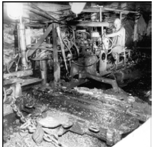
Abbildung 97: Elektrohydraulische Winde in der Abförderstrecke des gewonnenen Haufwerkes mit Schräppgerät im Vordergrund
