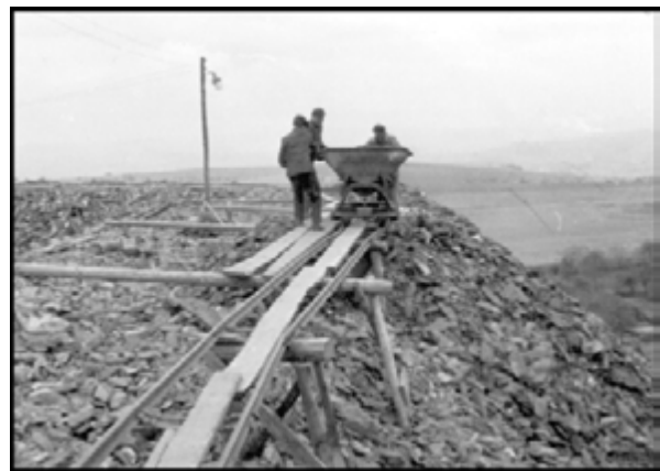
Abbildung 30: Haldensturz, Abteufhalde Brühlthal (Sangerhäuser Schacht)
