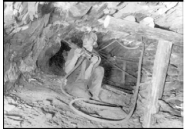
Abbildung 75: Hauer beim Abbohren des Strebtes, 1949
