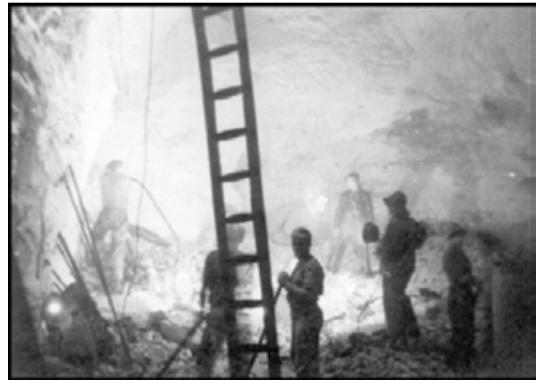
Abbildung 28: Füllortausbruch 5. Sohle (Sangerhäuser Schacht, 10. September 1949)
