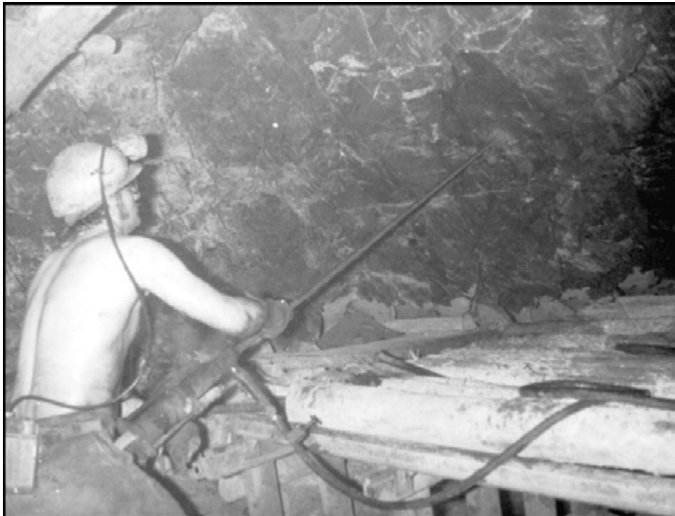
Abbildung 64: Bohren im Bandberg
