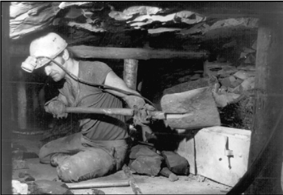
Abbildung 83: Beladen des Plattenförderbandes
