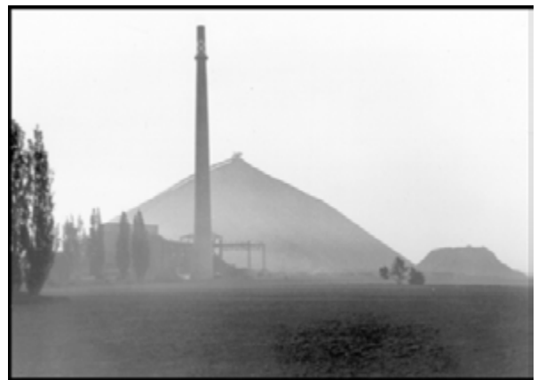
Abbildung 122: Kegelhalde mit Höhenförderer und Salzhalde (Bernard-Koenen-Schacht)
