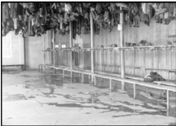
Abbildung 123: Mannschaftskaue (Hohenthal-Schacht, November 1949)
