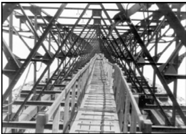
Abbildung 121: Laufsteg im Höhenförderergerüst (Vitzthum-Schacht)
