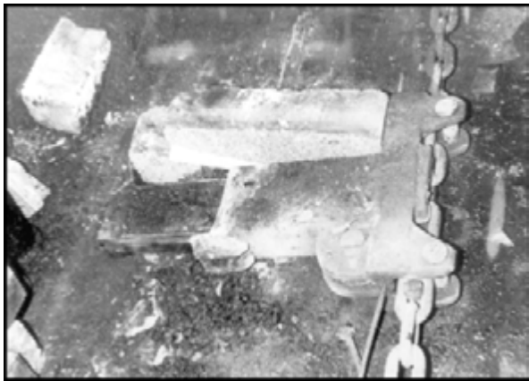
Abbildung 100: Gerät zum Einbringen und Verkeilen der Stützkörper im ausgezerten Raum
