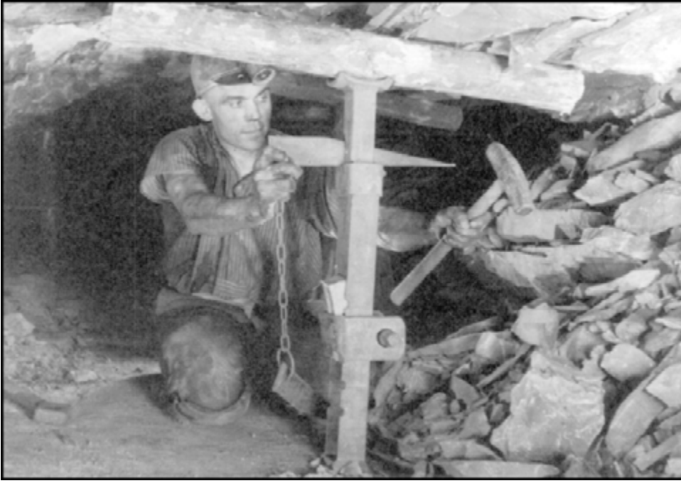
Abbildung 72: Strebausbau mit einfachen eisernen Strebstempeln und Holzkappen, 1950
