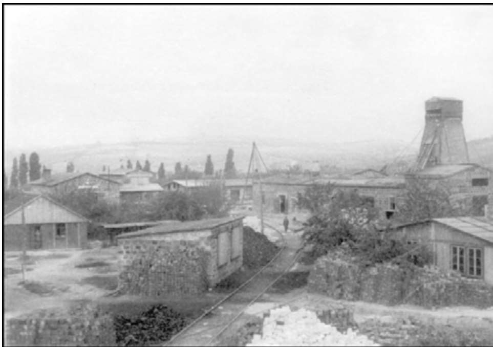
Abbildung 24: Abteufeinrichtungen (Sangerhäuser Schacht)
