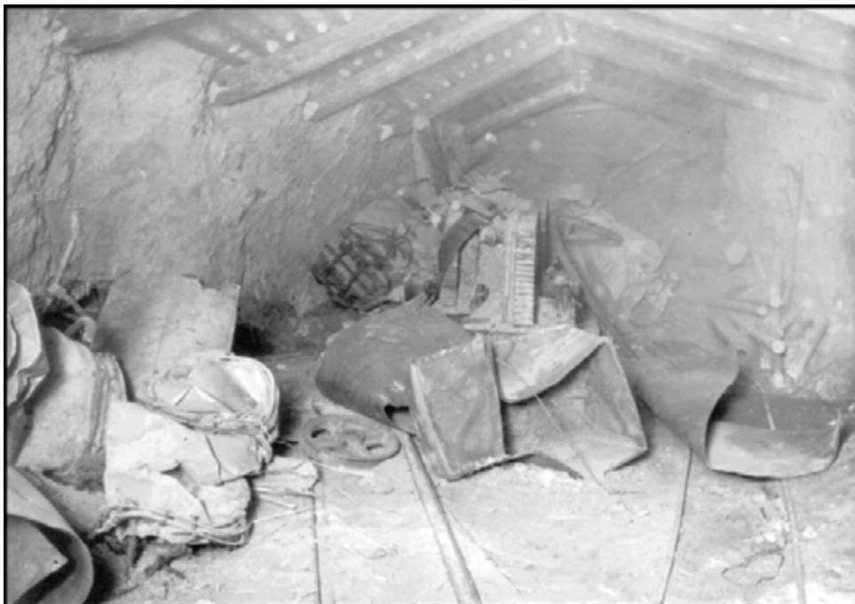
Abbildung 51: Nach einem Stickstoffausbruch beim Streckenvortrieb im Liegenden
