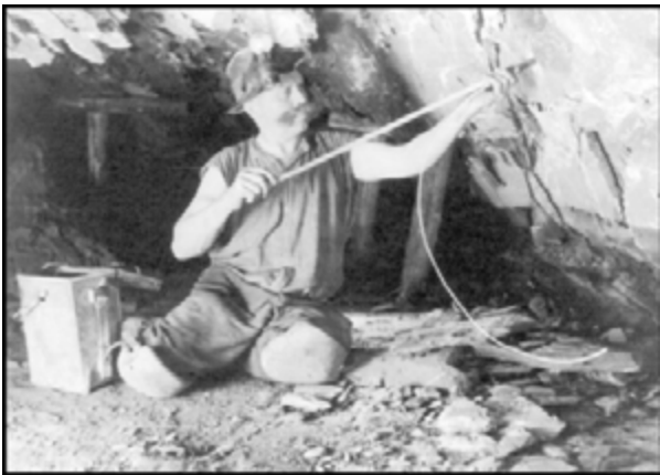
Abbildung 76: Sprenghauer beim Laden der Bohrlöcher nach der Erzgewinnung
