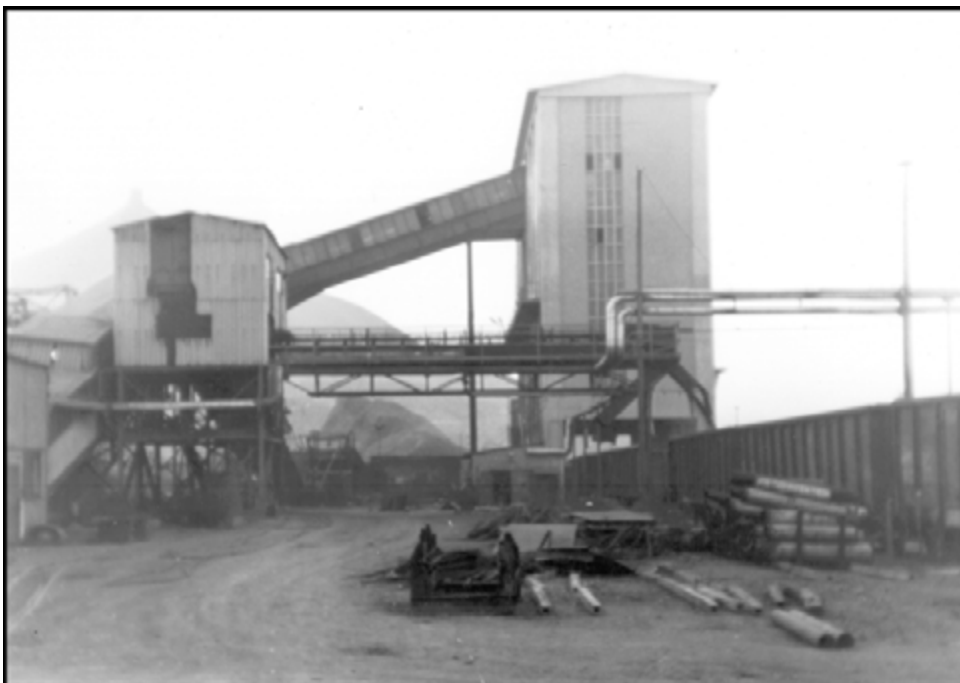
Abbildung 135: Erzverteilung, Erzverladebunker und Schrapperhalde zur Bevorratung Wochenendabfuhr (Bernard-Koenen-Schacht)
