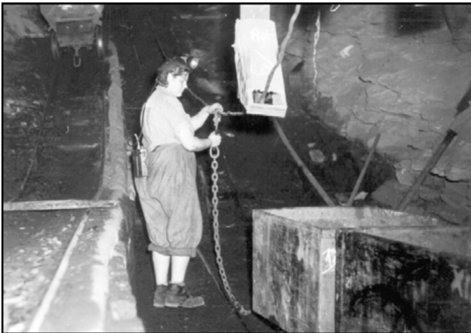
Abbildung 108: Sohlenanschlag Bremsberg, etwa 1955
