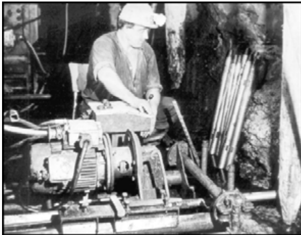
Abbildung 96: Bohrarbeiten mit der elektrohydraulischen Bohrmaschine für 80 mm Bohrdurchmesser und Bohrtiefen von ca. 13 bis 15 Metern zur Perforierung des Flözes.
