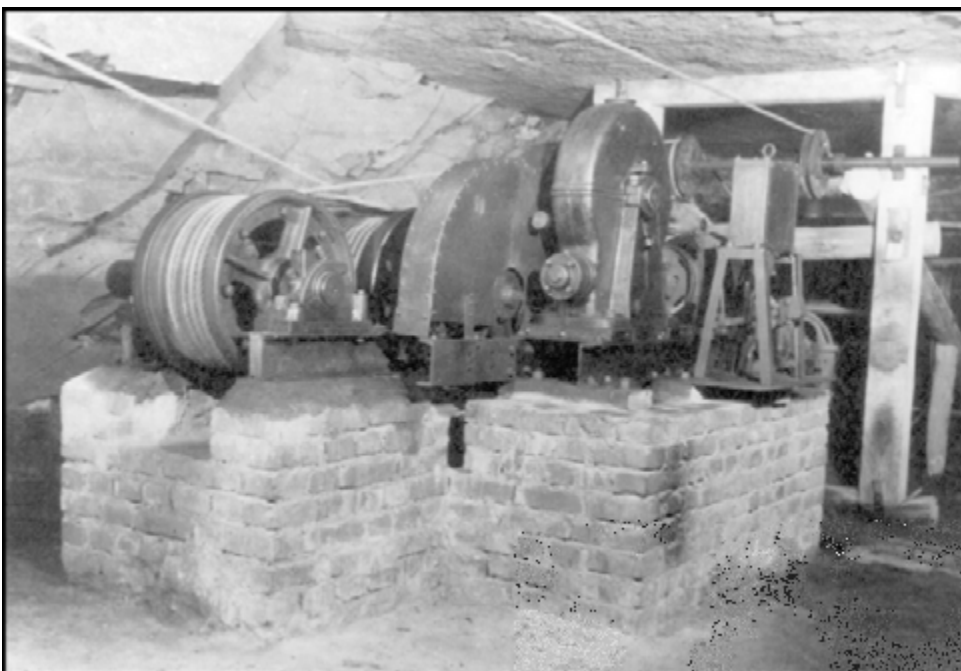
Abbildung 107: Bremsmagnetmaschine in der Bremsbergförderung (Vitzthum-Schacht, August 1949)
