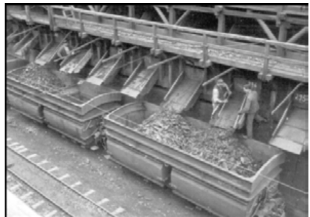
Abbildung 134: Schieferkanal, Abziehen der gekläubten Stücke aus den Verladebunkern in Sattelbo-denkipper der Werksbahn (Fortschritt-Schacht)
