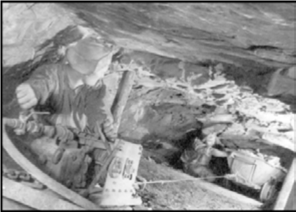
Abbildung 77: Förderung eines Strebhundes aus dem Abbau eines im Fallen der Lagerstätte aufgefahrenden Strebess mit Turbinenhaspel
