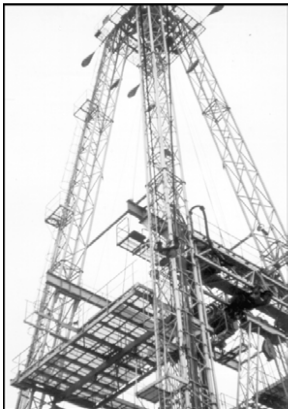
Abbildung 40: Schachtbohranlage (Bohrgerüst) Schachtbau Nordhausen
