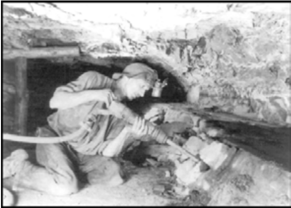
Abbildung 74: Hauer im Huntestreb bei der Gewinnung des freigelegten Kupferschieferflözes
