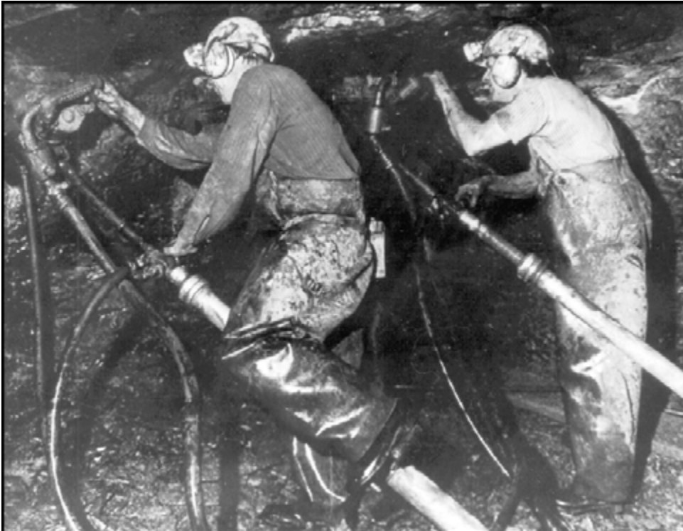
Abbildung 58: Bohren auf Teleskopstütze (Ausrichtungsort)
