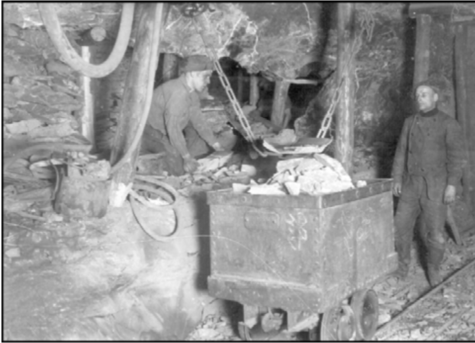
Abbildung 69: Schüttelrutsche als Fördermittel zwischen Streb und Strecke
