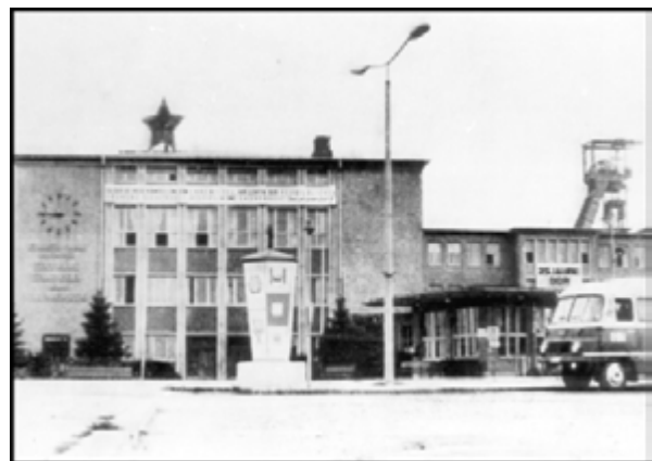
Abbildung 33: Speisesaal und Kauen (Bernard-Koenen-Schacht)
