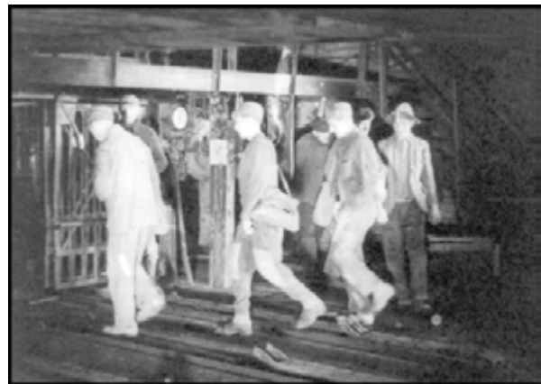
Abbildung 124: Einfahrt Hängebank (Fortschritt-Schacht)
