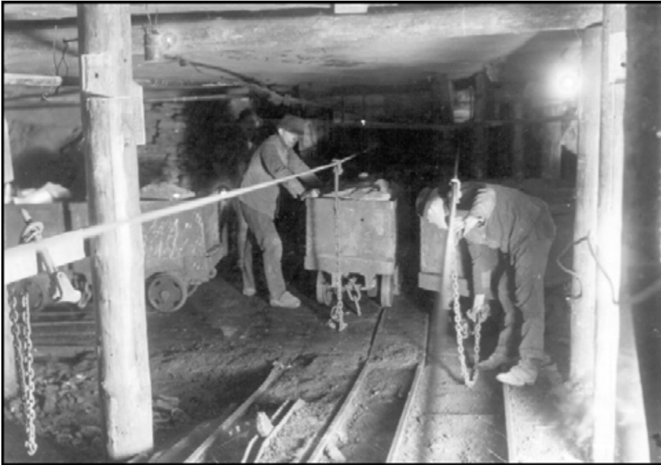
Abbildung 106: Zwischenanschlag Abbaustreckenabgang aus einem Maschinenberg, etwa 1920
