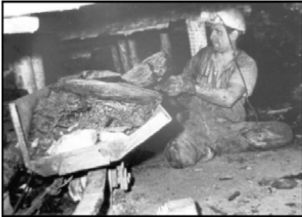
Abbildung 86: Beladen der Gondeln des Einschienenförderers vor Streb
