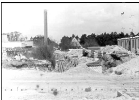
Abbildung 48: Baustelleneinrichtung mit Bürocontainern (Kupfererzschachtanlage Spremburg)
