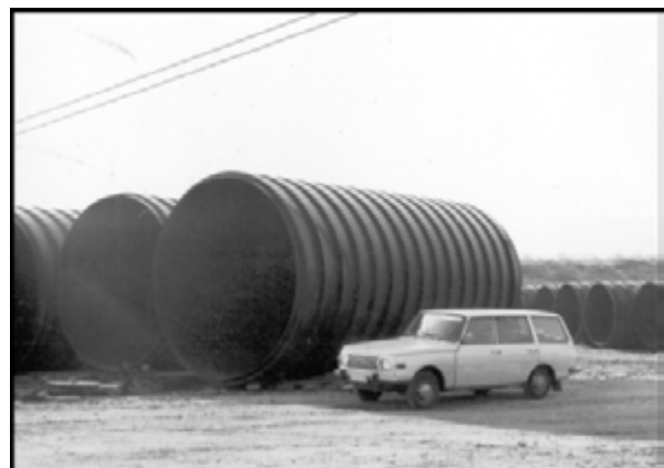
Abbildung 44: Bohrschachtausbau (Schachtausbauschieße)
