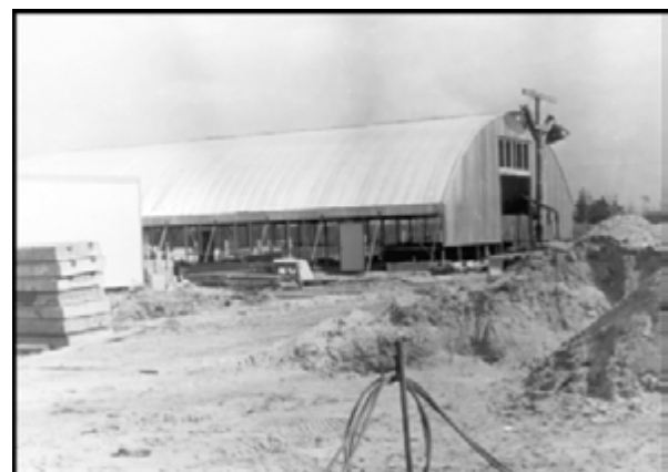
Abbildung 49: Baustelleneinrichtung, Werkstatthalle (Kupfererzschachtanlage Spremburg)
