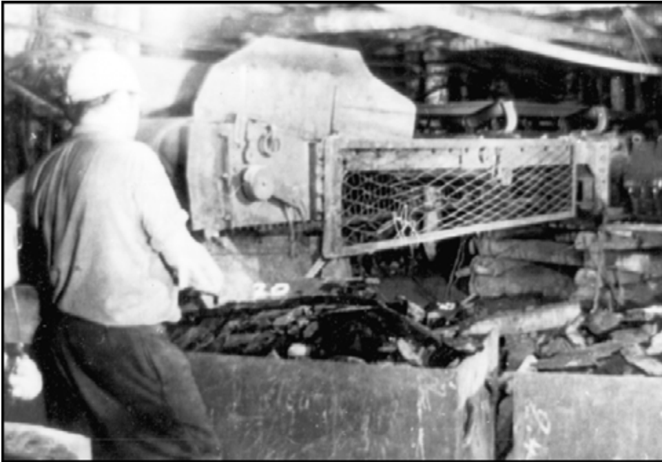
Abbildung 109: Haufwerksübergabe Bandberg-Lok-Förderung
