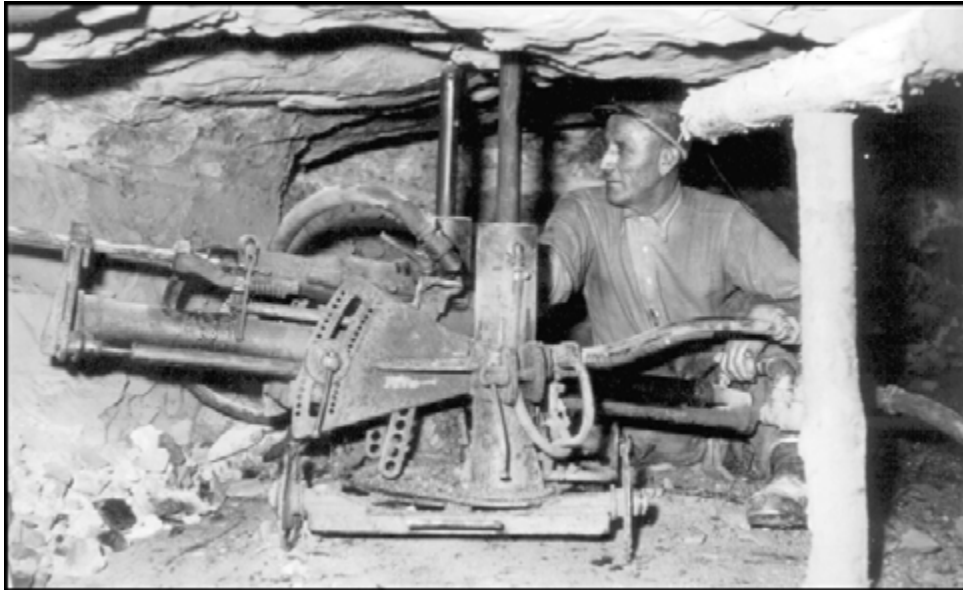
Abbildung 89: Bergebohrgerät „Herkules“ (Entwicklungsstand etwa um 1961)
