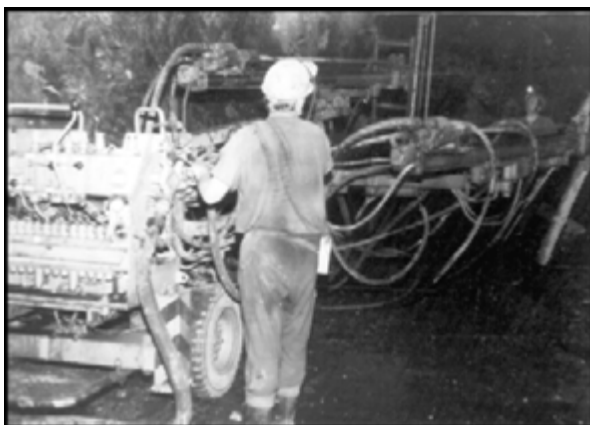
Abbildung 66: Bohrwagen BWA-3 im Einsatz (Vorrichtungsort Schäl-schraperstrebbaue)
