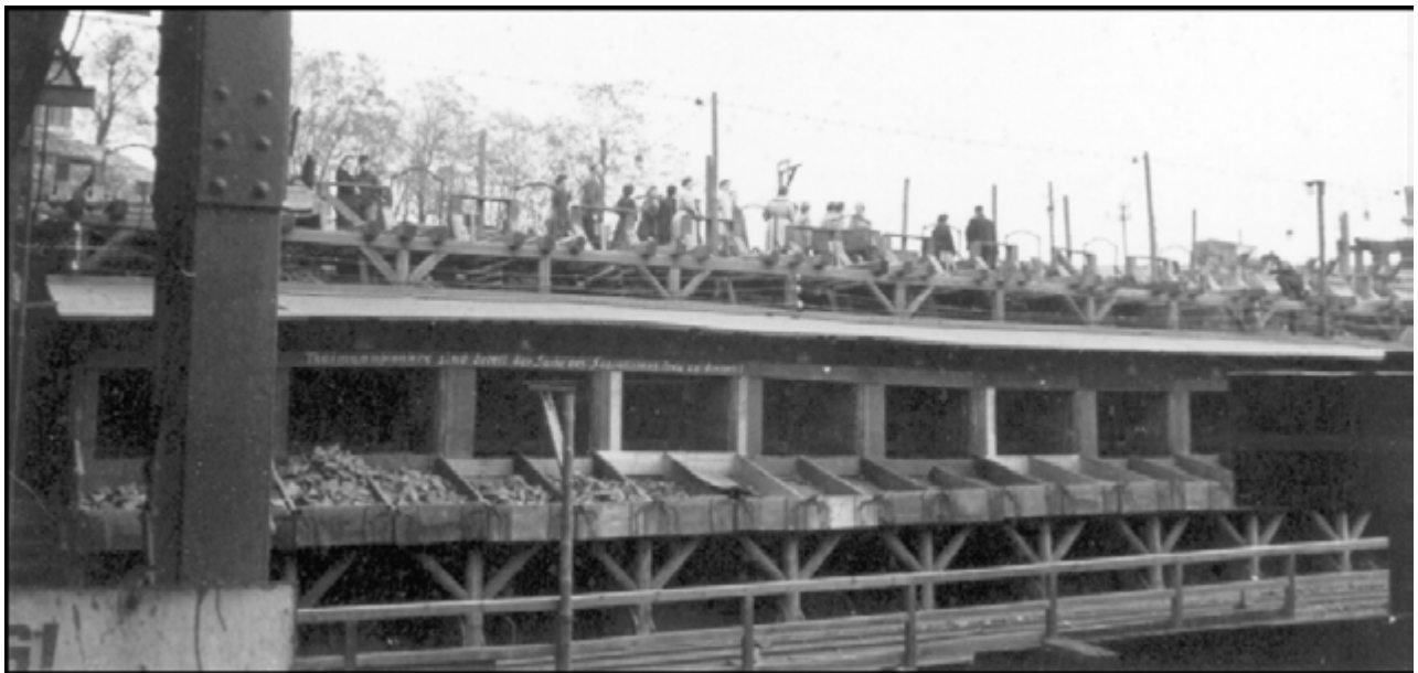
Abbildung 132: Kläuberställe, Sturzbunker und Scheidehaus mit Schurre für Ausschläge (1959)
