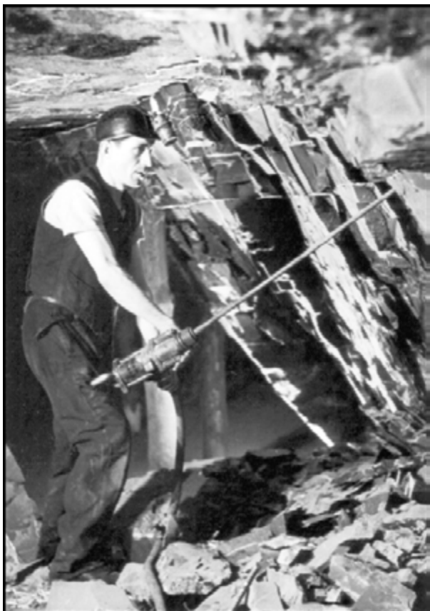
Abbildung 63: Bohrarbeit im Vorrichtungsstreckenvortrieb
