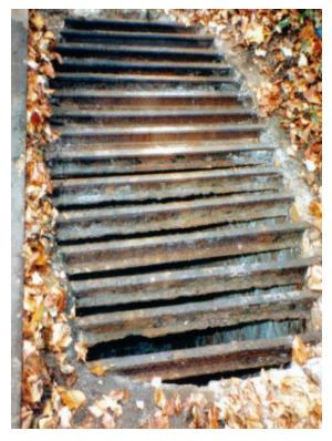
Abb. 9: Beispiel für ein Lichtloch mit viereckigem bzw. elliptischem Querschnitt
