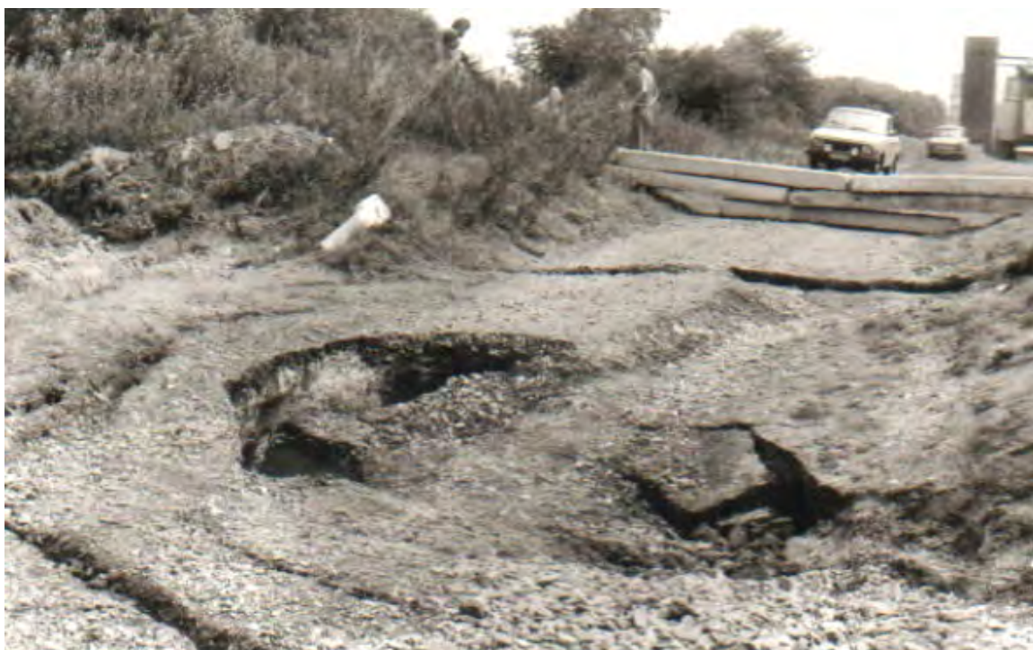
Abb. 14: Erdenbrüche am Südrand des Staubeckens
