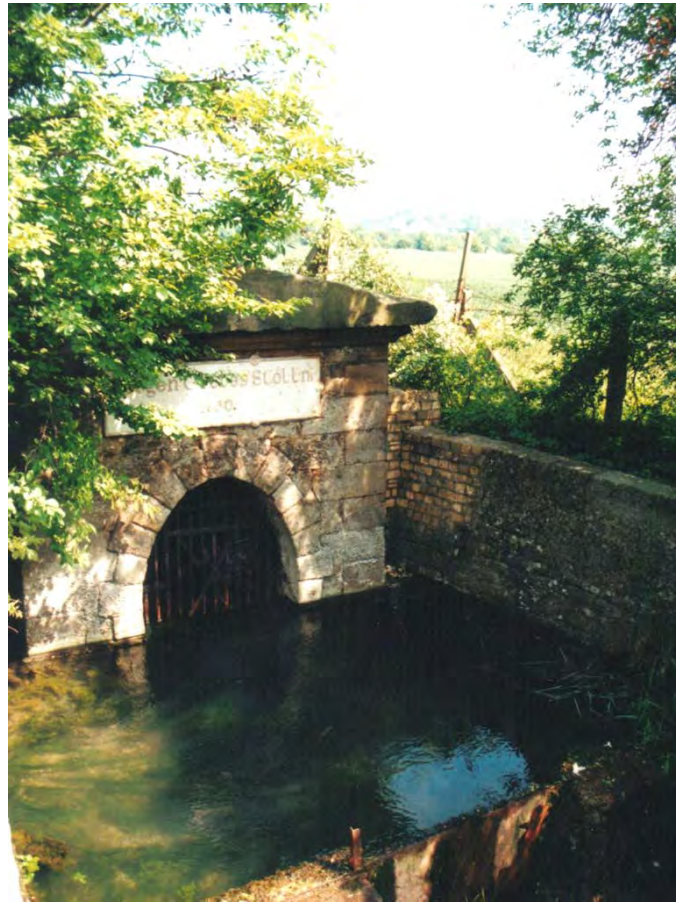
Abb. 9: Das Mundloch des Seegen-Gottes-Stollns
