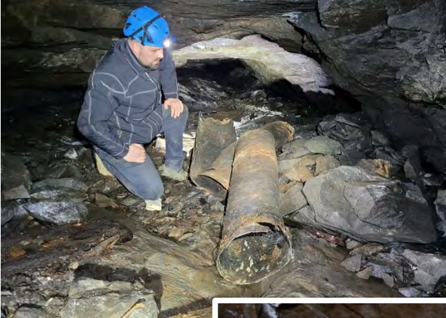
Wetterröhren (Lutten) aus Zinkblech um 1860. Östliche Mittelstrecke, Johanschacht, Wettelrode.
