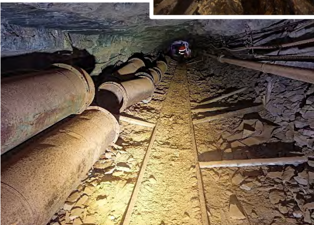
Unbehandelte Stahlblech-Lutten, 20. Jahrhundert, Erste Sohle, Röhrigschacht Wettelrode.
