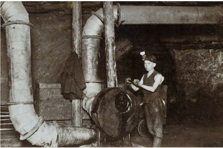
Historisches Foto von Blechlutten mit Handkurbel-Lüfter im Clothilde-Schacht Eisleben, um 1910.
